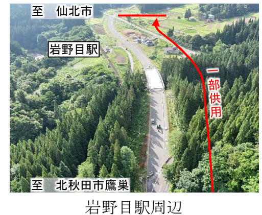
一部供用箇所
