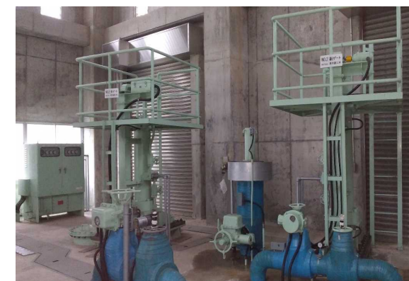
油圧シリンダー分解整備 設置後35年経過
