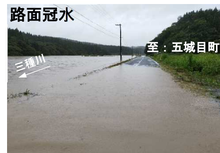
(主) 能代五城目線 ますざわ 増沢工区（三種町）
