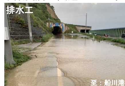
国道101号 生鼻崎工区（男鹿市）
