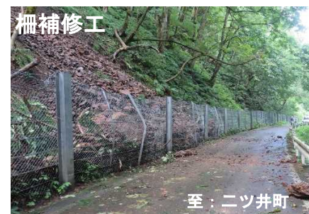
(一) 西目屋二ツ井線 いち さか 一の坂工区（藤里町）
