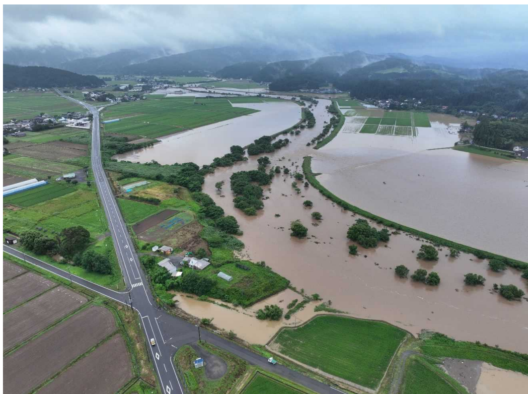
令和6年7月豪雨による石沢川氾濫状況（R6. 7. 25撮影）
