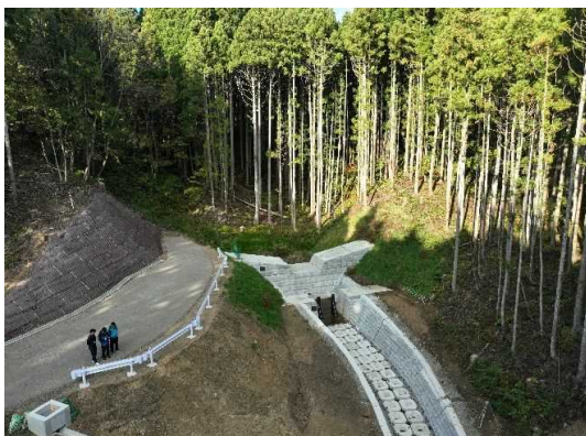
牛寺沢1-1砂防えん堤 R7.3月完成
