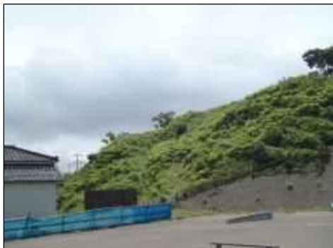
令和元年度 工事施工前
