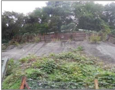
令和2年度 工事施工前
