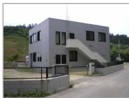
大内ダム管理棟
