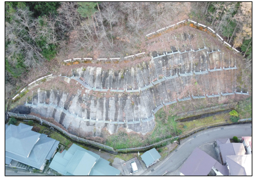
令和2年度 工事完成後（吊り柵工）
