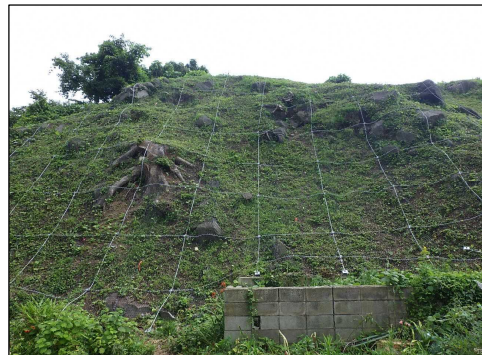
令和2年度 工事完成後（落石予防網工）
