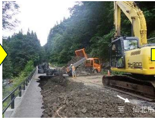
8月22日 応急復旧作業
