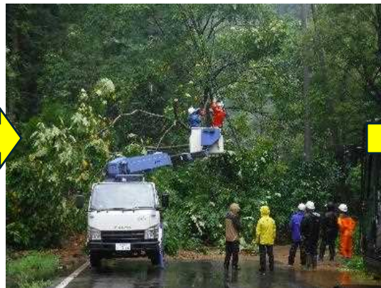
8月21日 道路啓開作業
