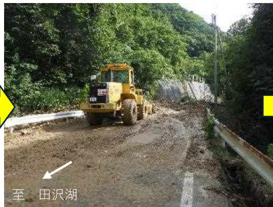
8月21日 道路啓開作業
