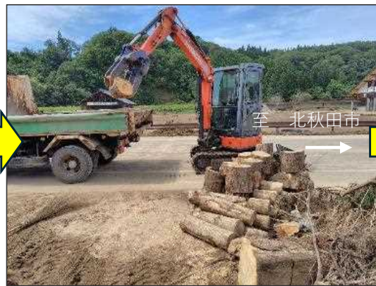
8月21日 道路啓開作業
