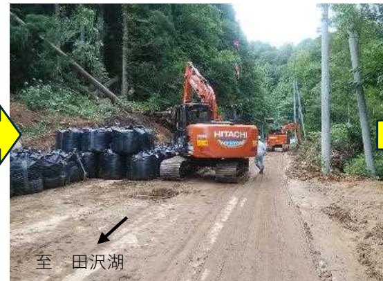
8月21日 法面对策
