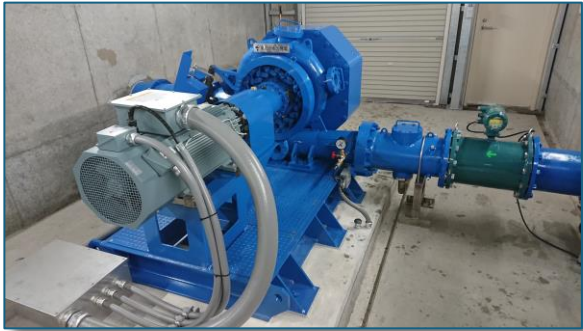
新型水車発電機 実証機
