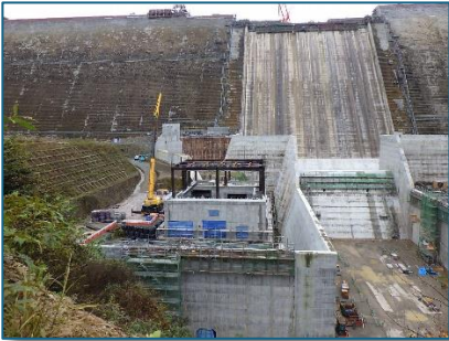
成瀬発電所（建設中）
