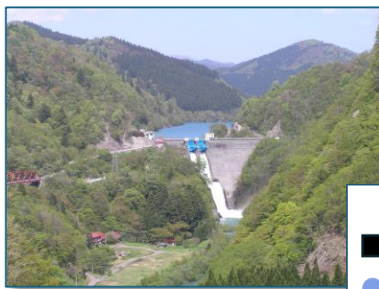
素波里発電所
