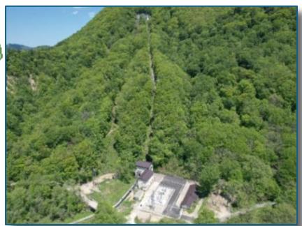
小和瀬発電所
