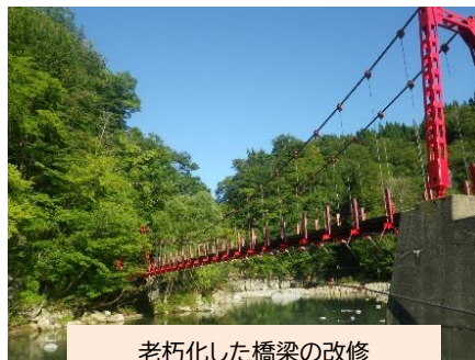
老朽化した橋梁の改修
