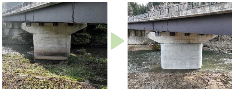
橋脚の巻立工法による耐震化
