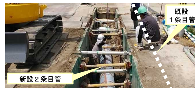
下水道管路の二条化による耐震化
