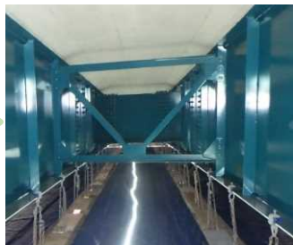
道路施設(橋梁の桁再塗装)
