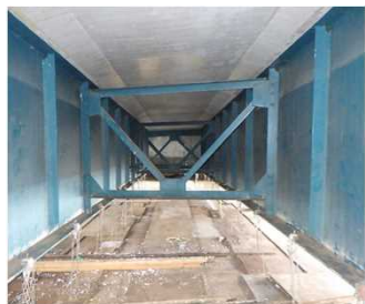
道路施設(橋梁の桁再塗装)
