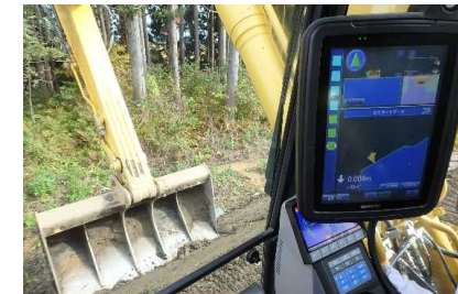
ICT建設機械による施工状況
