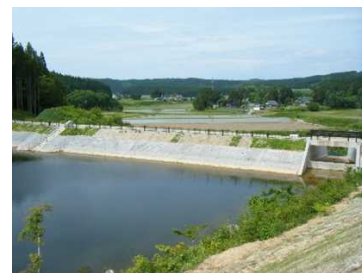
ため池の改修
