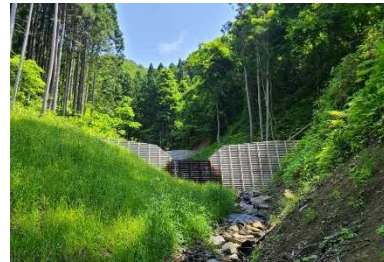
治山ダム工事
