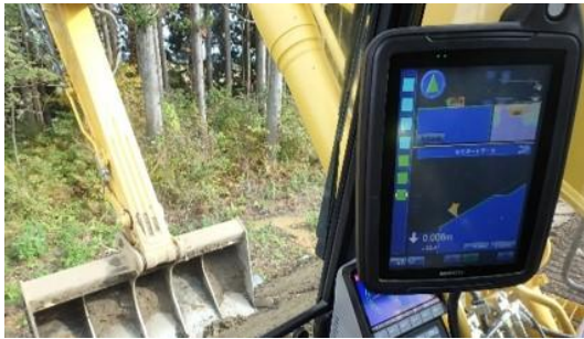
ICT 建設機械による施工状況
