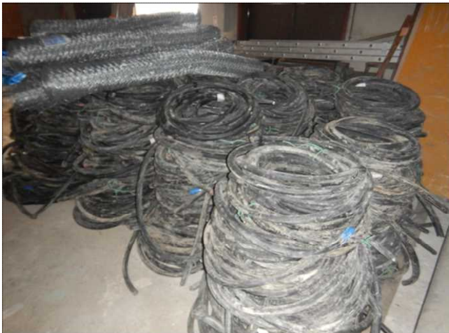
小和瀬発電所修理工場保管
