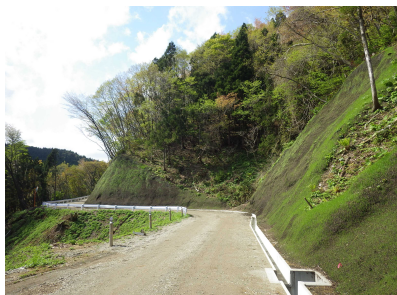
林道 峰浜線 八峰町 幅員 5.0m、開設延長 539m
