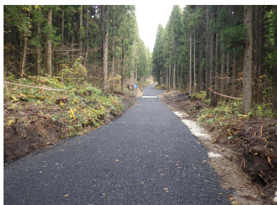
林業専用道 熊沢口線 北秋田市 幅員 3.6m、開設延長 492m
