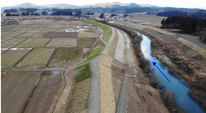
復旧工事完了
