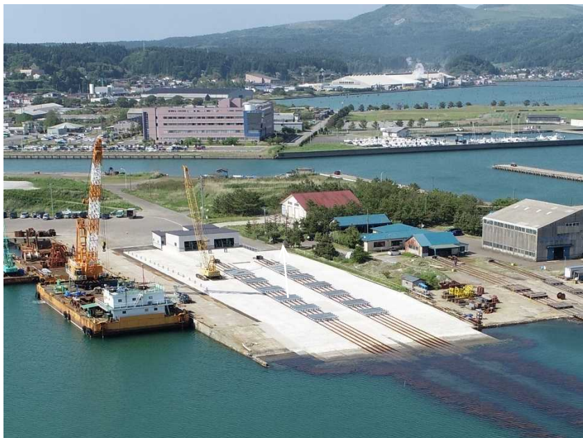
船川港 船揚場 完成（男鹿市・令和6年6月）
