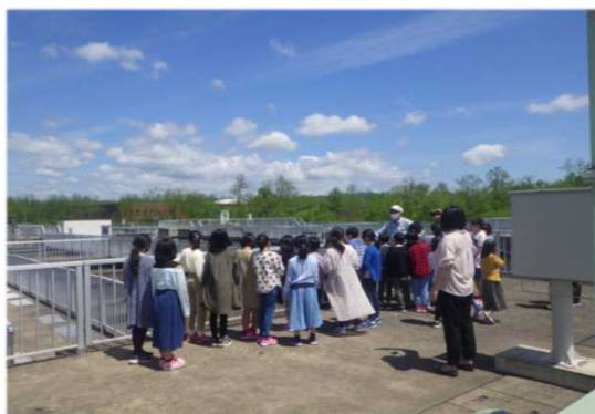
大曲処理センター
