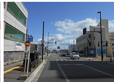
▲整備済み隣接工区
