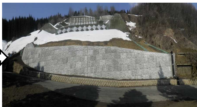
復旧工事完了
