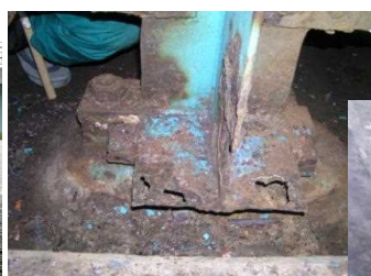
▲主桁及び支承部の腐食状況
