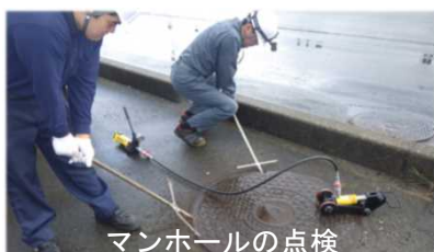
マンホールの点検
