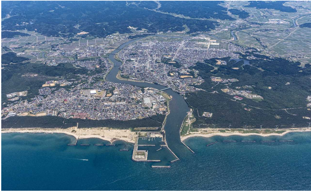
本荘港全景(令和6年6月撮影)
