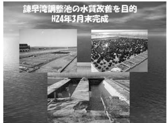
図 13 諫早湾調整池の水質改善を目的とした実証試験用水路と浄化前処理施設
