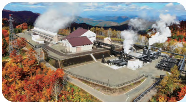
山葵沢地熱発電所 (写真提供：湯沢地熱株式会社)
