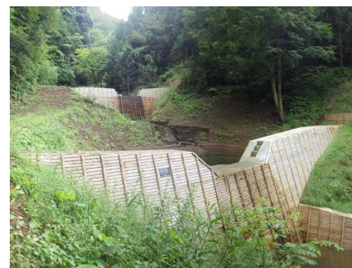
〔 治山ダム工 (由利本荘市) 〕
