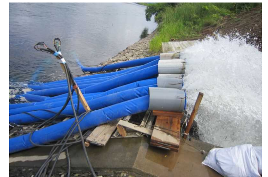
〔渇水時の応急用ポンプ活用 （能代市）〕
