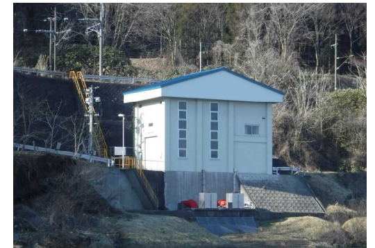
〔綴子揚水機場（北秋田市）〕
