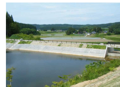
〔ため池の改修〕
