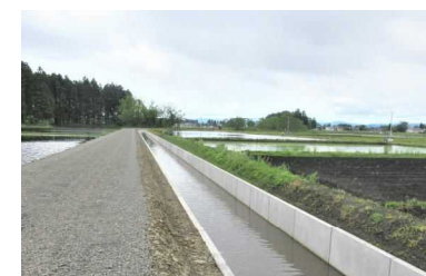
〔用排水路の整備〕
