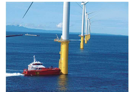
CTVによる洋上風車への接舷（能代港）
