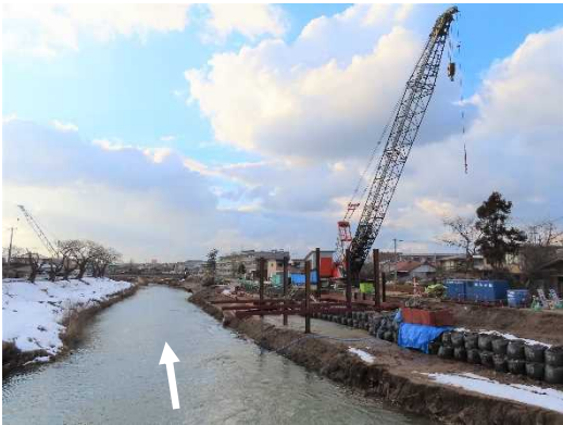
① 櫛山古川新町 仮棧橋施工状況
