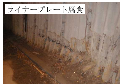
(一) 高屋敷茶屋下線 揚石隧道 (能代市)
