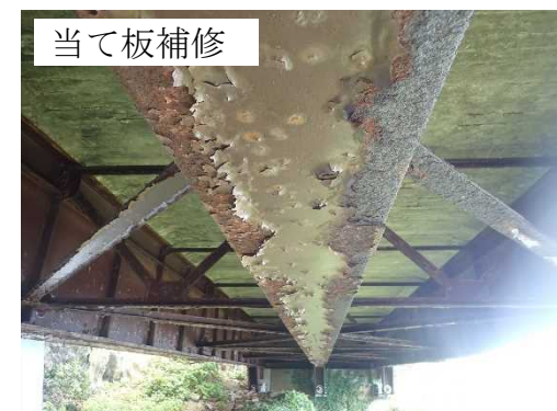
たてしま (主) 男鹿半島線 立島橋 (男鹿市)
