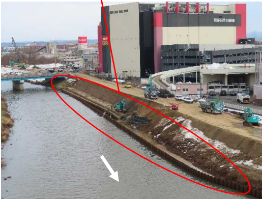
② 卸町 矢板護岸施工状況
