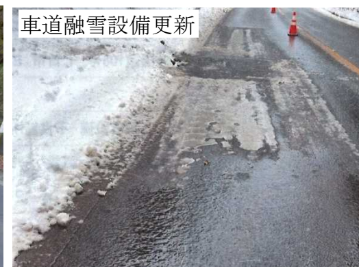
国道105号 なのかいち 七日市工区 （北秋田市）
