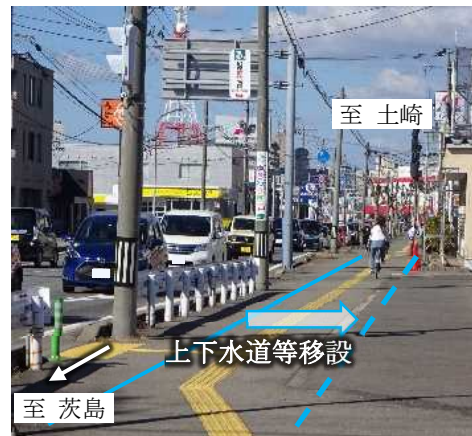
新屋土崎線 旭南工区 （秋田市） 【埋設物移設補償】
