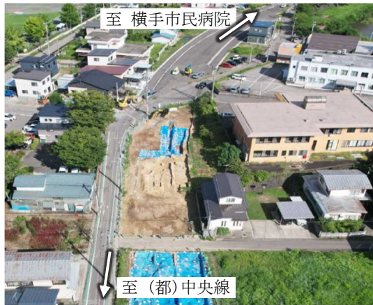
八幡根岸線 根岸町工区 （横手市） 【道路改良・舗装工】
