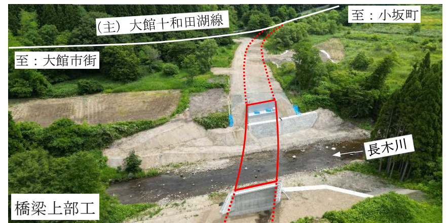
(主) 大館十和田湖線 雪沢工区 (大館市)
