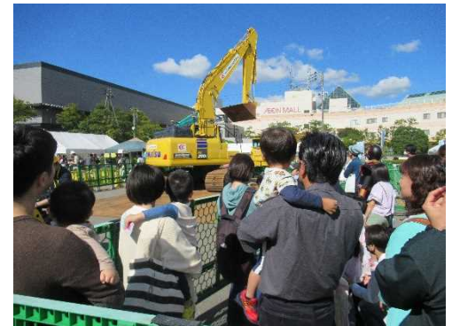
最新建設 ICT 機械の デモンストレーション
