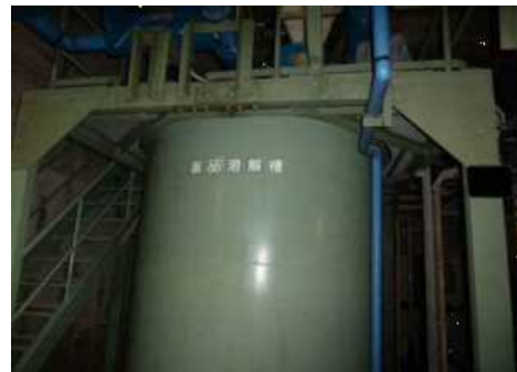
大館処理センター汚泥脱水設備（大館市） 平成4年設置（32年経過）
