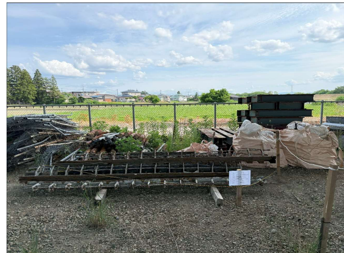
NO.8 伸縮装置、鋼板
