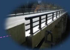
国道341号 橋梁補修(仙北市)
