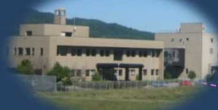
大館処理センター(大館市)
