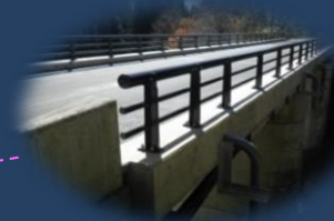
国道341号 橋梁補修(仙北市)
