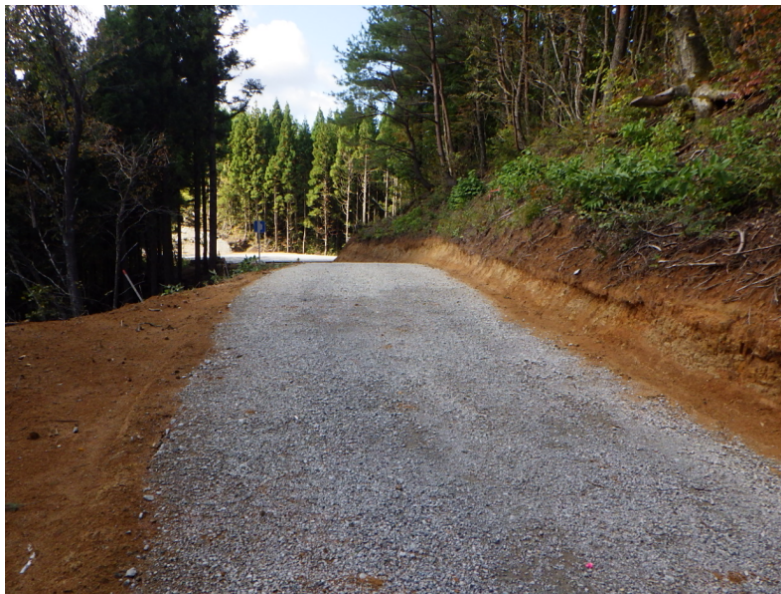
林道の開設（林業専用道）
