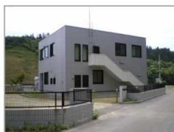
大内ダム管理棟
