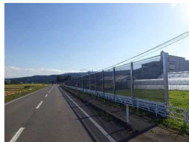
防雪柵 設置状況
