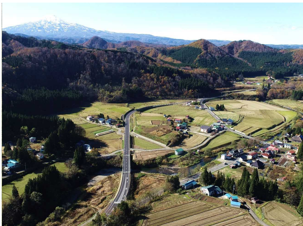
国道108号 鳥海町小川工区 (R5. 11月)
