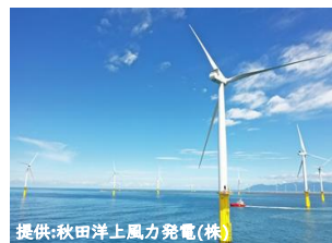
提供:秋田洋上風力発電(株) 能代港洋上風力発電所(能代市)
