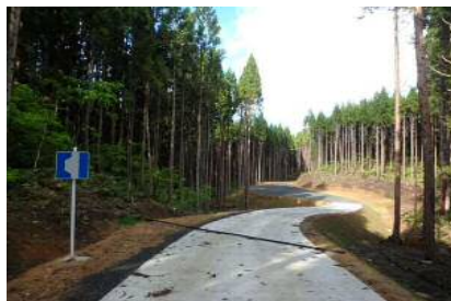
〔 林業専用道 関ノ沢線 北秋田市 幅員 3.6m、開設延長 1,110m 〕
