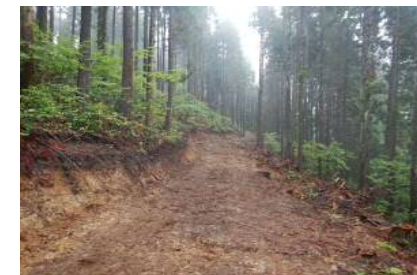
〔 森林作業道 北荻ナシ線 由利本荘市 幅員 2.5m、開設延長 855m 〕
