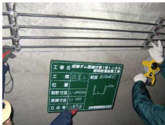
現計画 (配線取付金物：ダクター取付)
