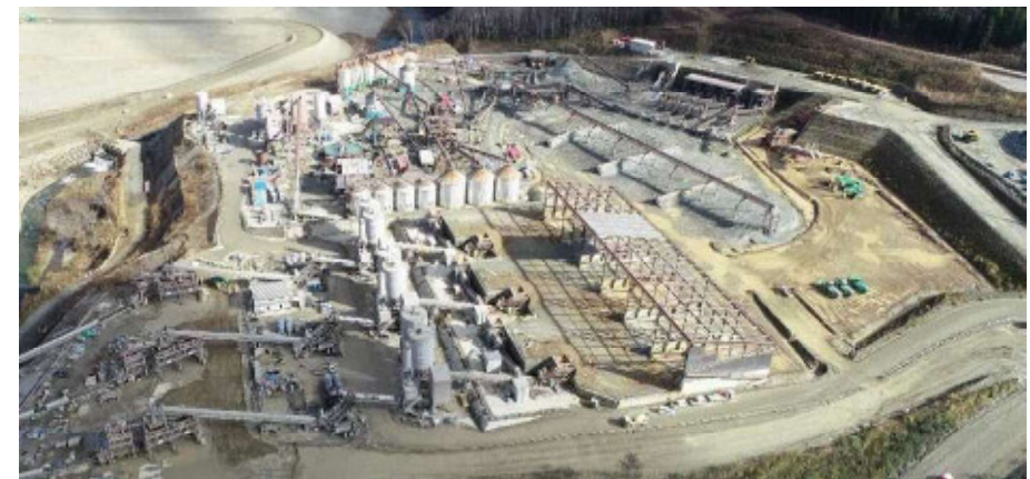
仮設備の設置状況
