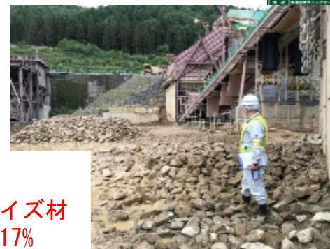
オーバーサイズ材除去状況
