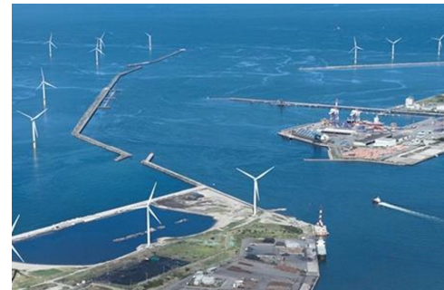
洋上風力発電（秋田港）
