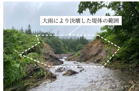
【令和5年7月に決壊した小黑沢ため池（仙北市）】
