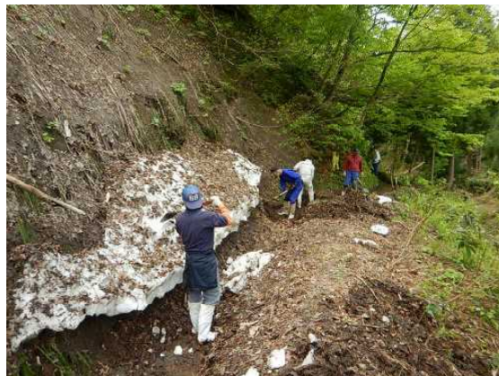
<図>農業用水路の土砂上げ作業
