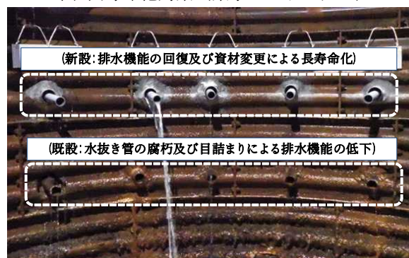
<図>長寿命化対策（集水ポーリング工）
