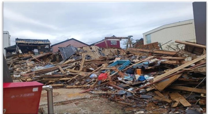
輪島市の被害の様子
