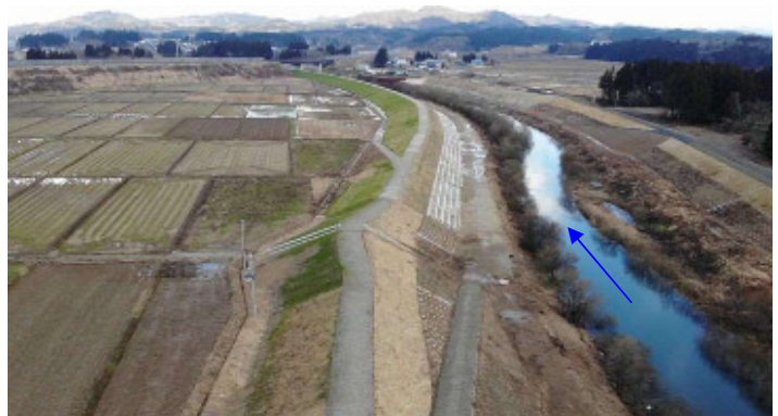
復旧工事完了
