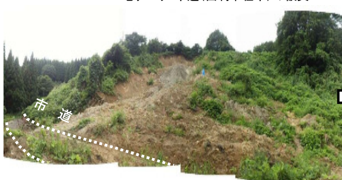
被災時(地すべりにより市道が埋塞)
