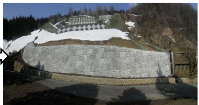
復旧工事完了
