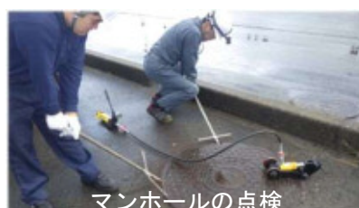
マンホールの点検
