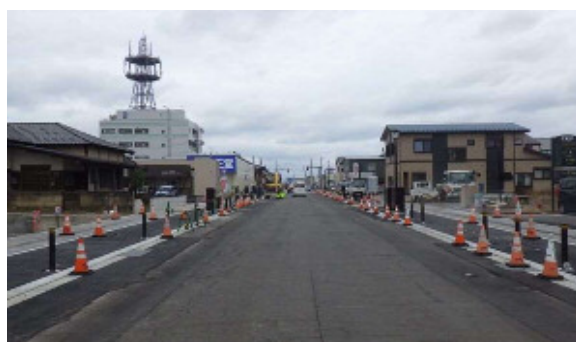
【進捗状況】 停車場栄町線（由利本荘市）
