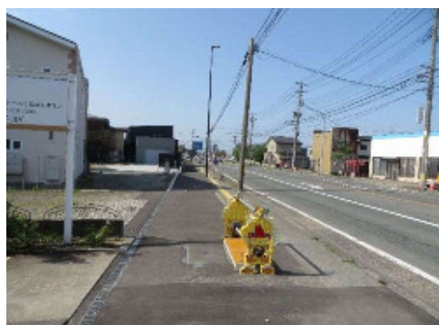
【進捗状況】 新屋土崎線（秋田市）
