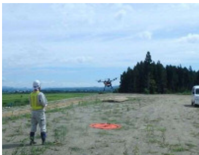
UAVによる起工測量状況
