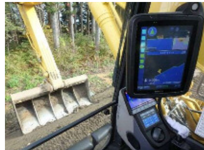
ICT建設機械による施工状況
