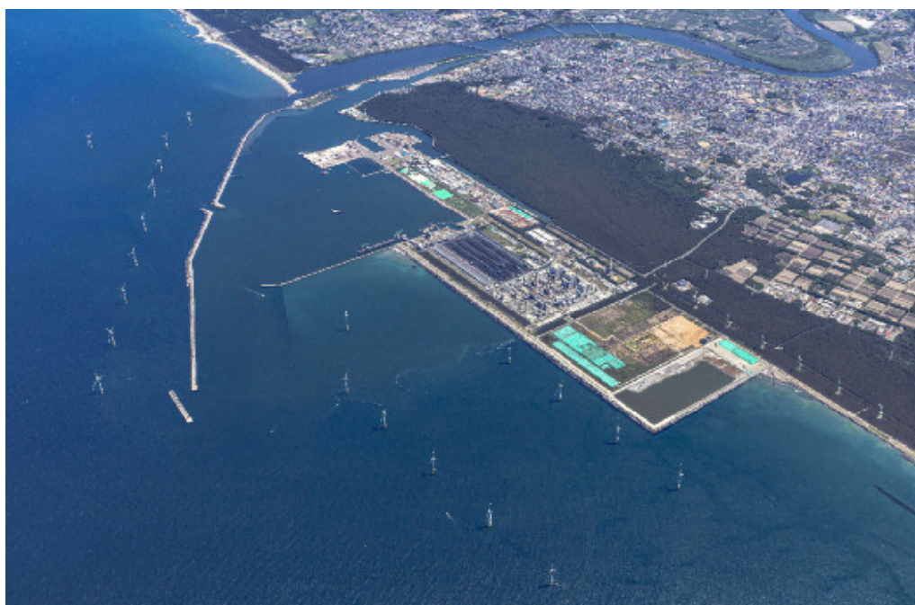
能代港全景(令和5年6月撮影)
