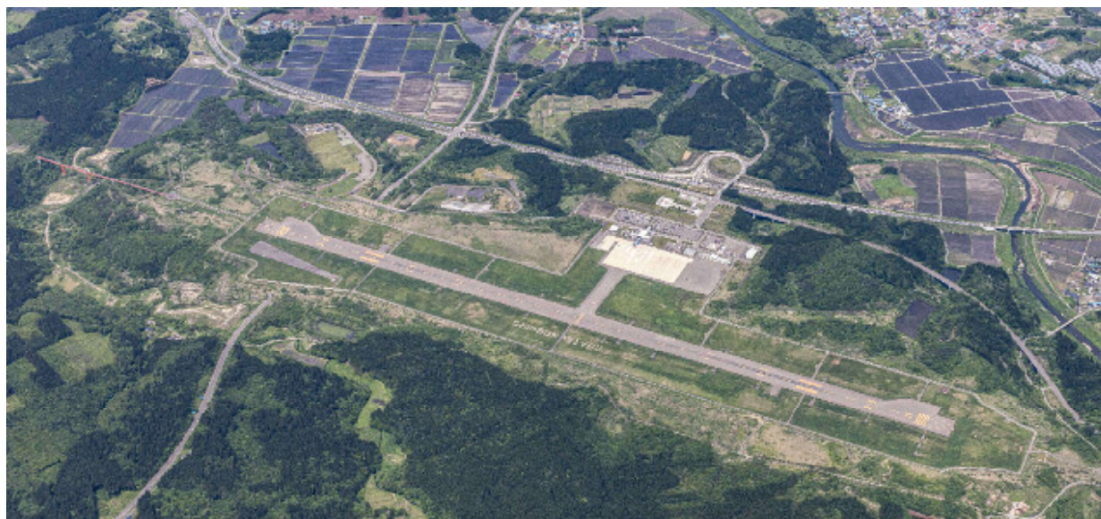
大館能代空港全景(令和5年6月撮影)
