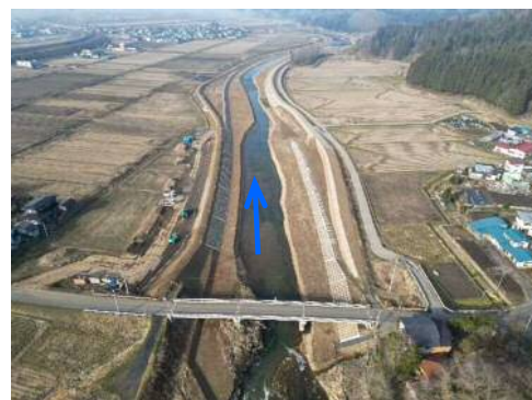
下内川(大館市) 《築堤・河道掘削・護岸工事》
