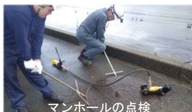
マンホールの点検
