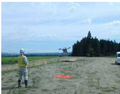
UAVによる起工測量状況
