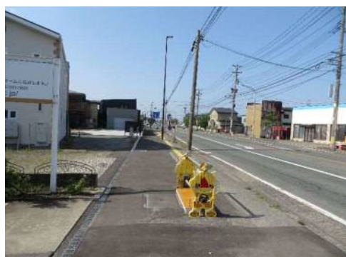
【進捗状況】 新屋土崎線（秋田市）
