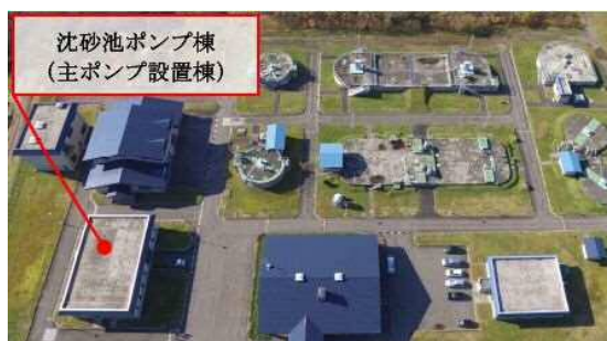
【鹿角処理センター 沈砂池ポンプ更新】
