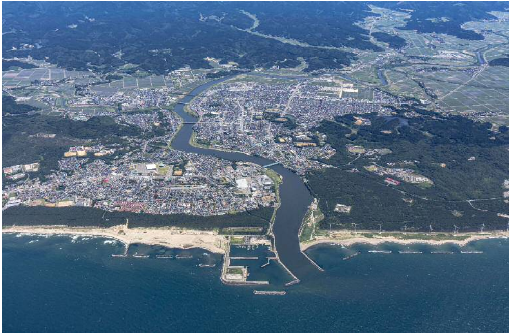
本荘港全景(令和5年6月撮影)
