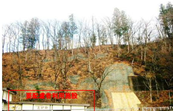
《要配慮者利用施設や市道をはげ崩れから守る法面工》 《横手市・愛宕地区》
