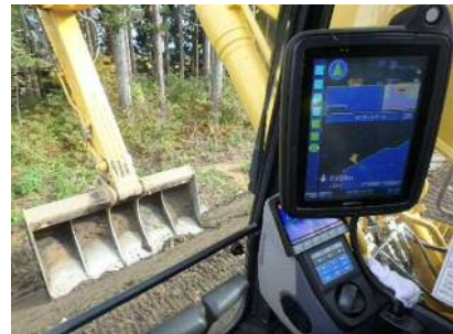
ICT建設機械による施工状況
