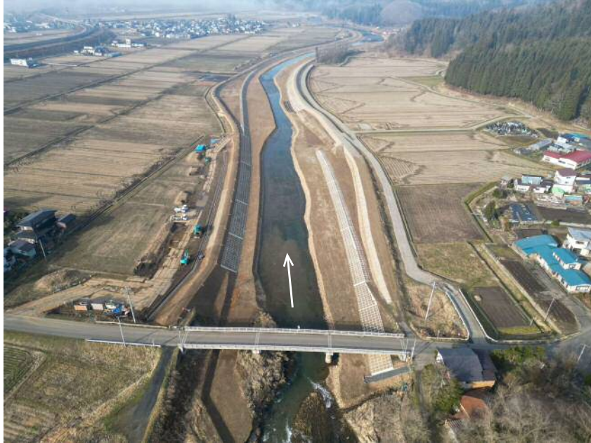
一級河川 下内川（大館市・施工中）
