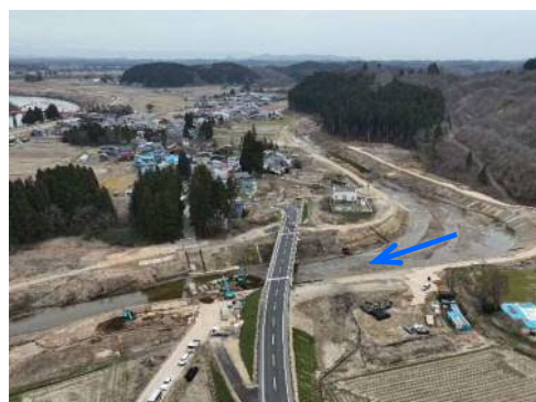
新波川(秋田市) 《築堤・河道掘削・橋梁架替工事(白山橋)》
