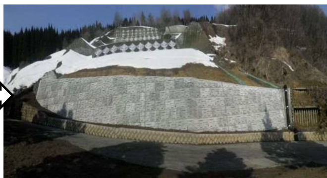
復旧工事完了
