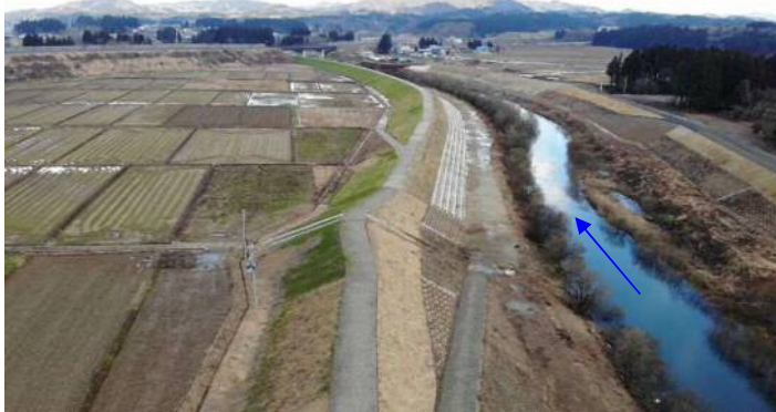
復旧工事完了
