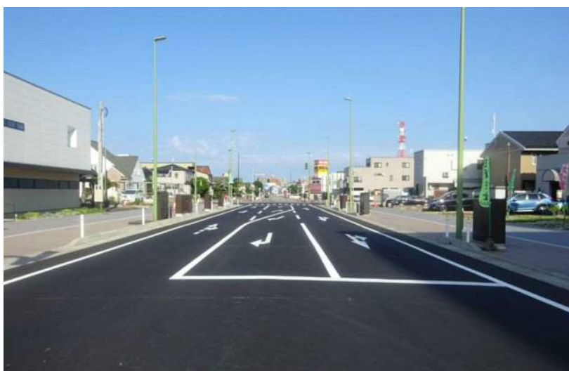
川尻広面線(横町工区) (秋田市)
