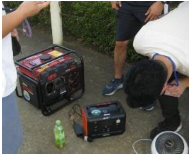
発電機の確認
