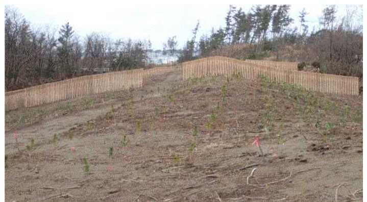
施工区域内の様子
