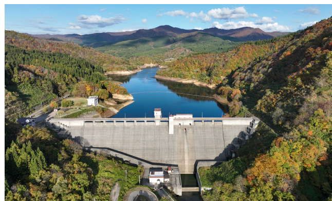
大松川ダムと紅葉(令和5年10月撮影)
