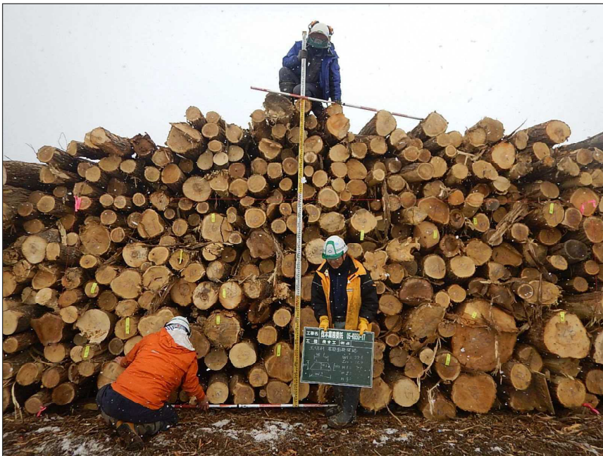
写真:伐木工 工種:玉切 種別:玉切材 材積確認 箇所:真昼川 (雑木) 施工管理値:高さ(H1): 実測 3.0m
