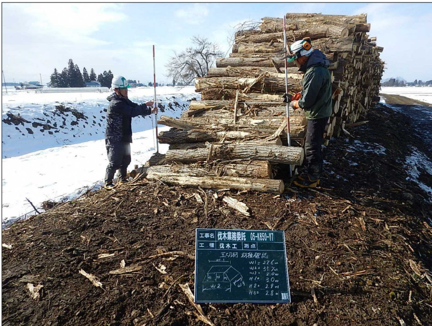
写真:伐木工 工種:玉切 種別:玉切材 材積確認 箇所:真昼川 (雑木) 施工管理値:幅(W3): 実測 2.0m
