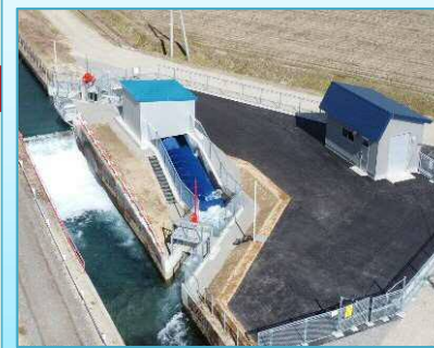
仙平太田斉内小水力発電所
