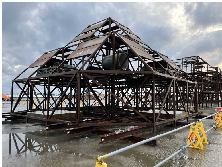
魚礁の整備工事
