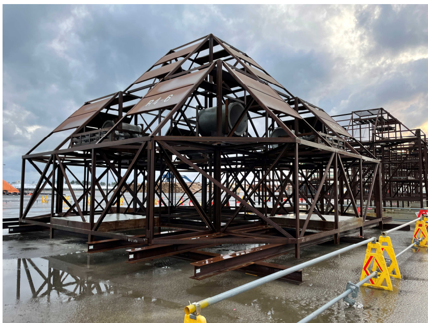
魚礁の整備工事
