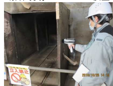
解体現場でのアスベスト検査
