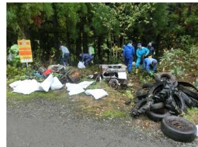
不法投棄された廃棄物の撤去作業
