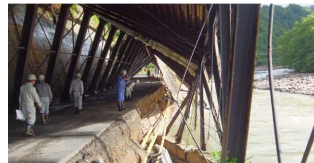
水害によるスノーシェッド(雪崩対策施設)の被災
