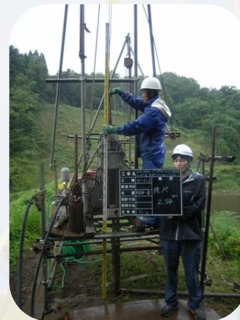
ボーリング調査
