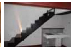
洗面台の増設
