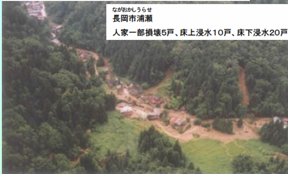
平成16年7月新潟・福島豪雨における土砂災害
