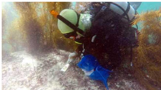
図1 スクレーパでの岩盤清掃の様子
