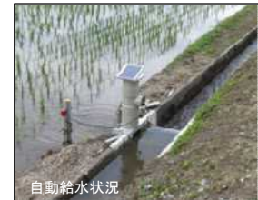
自動給水状況
