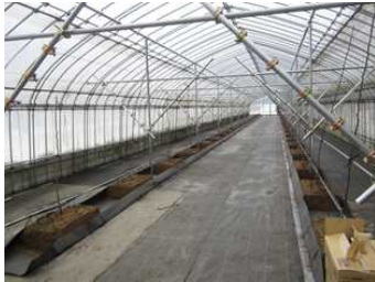
遮根シートの上に培土を設置
