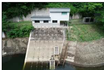
ドローンを使用し、施設状況を確認
