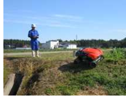
法面の草刈り作業
